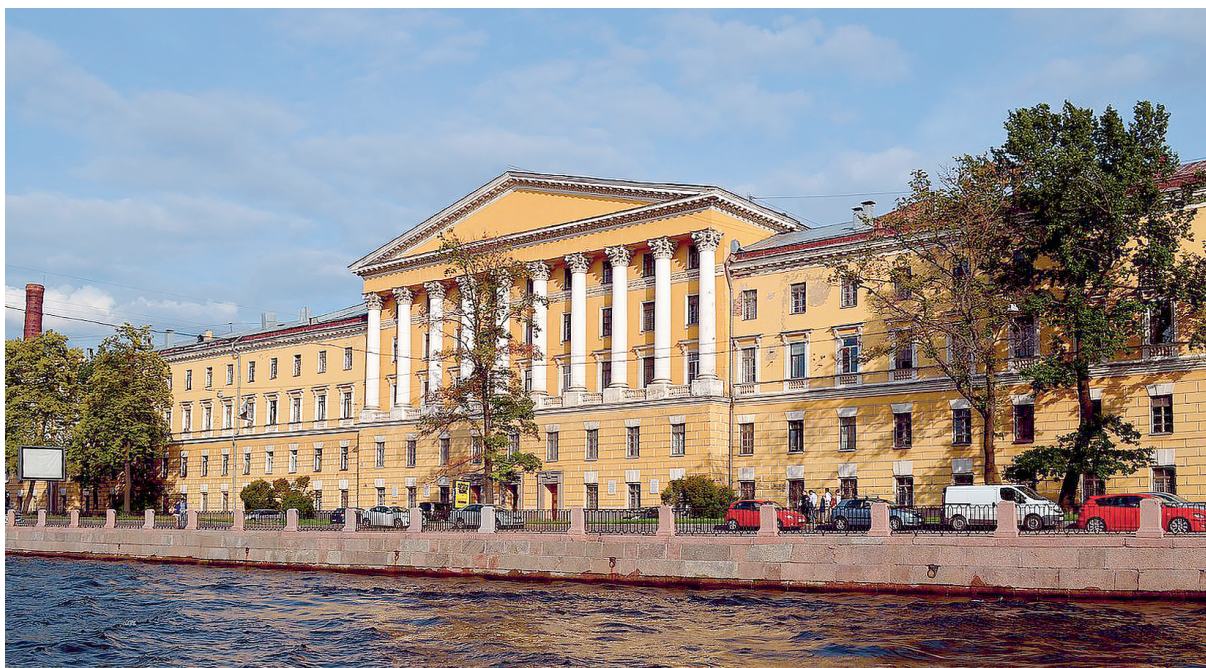
Рис. 2. Здание на набережной Фонтанки, 106, относится к постройкам в стиле классицизма (постройка — 1782–1784, 1850 гг.). Ранее — Обуховская больница, в настоящее время в здании расположены Клиника военно-морской и общей терапии и Клиника челюстно-лицевой хирургии Военно-медицинской академии им С.М. Кирова (фото из личного архива Н.И. Конкиной)
